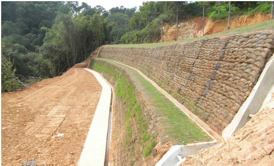
ภาพที่ 4 การติดตั้งตาข่ายกันดินและหินบริเวณที่ลาดเชิงเขา
