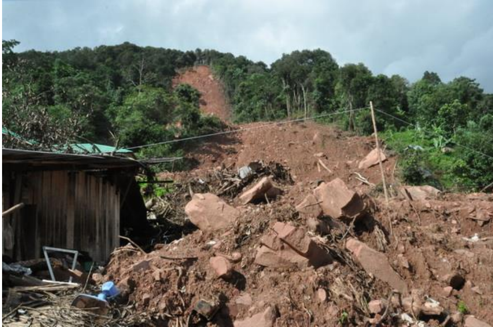
ภาพที่ 3 การถล่มลงมาของดินและหินร่วมกันตรงบริเวณที่ลาดเชิงเขา
