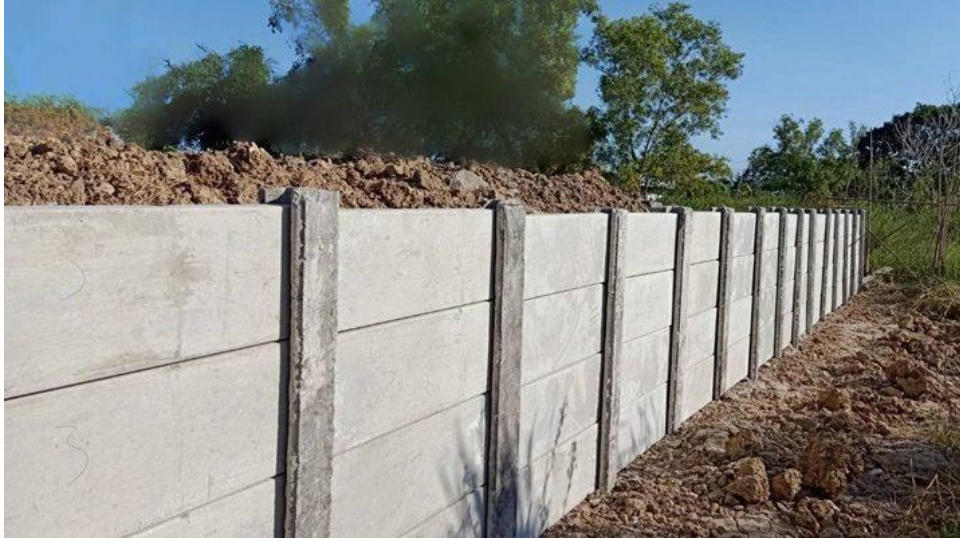
ภาพที่ 5 การทำกำแพงคอนกรีตป้องกันแผ่นดินถล่ม
